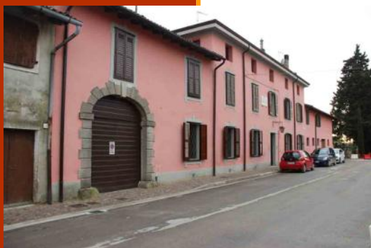
Casa Portelli dove nel cortile interno si trova il nuovo pozzo
