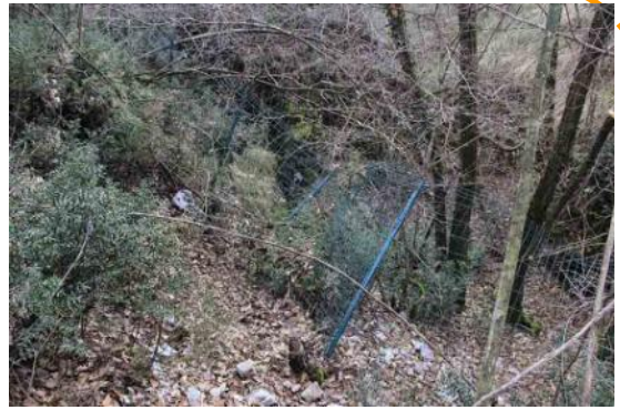
Grotta della Biscia Morta - I481/4266 VG, la rete metallica che circonda l'ingresso della grotta, appare sfondata e in preda al degrado in più punti. Ad ogni modo rappresenta un degrado paesaggistico.
