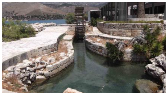
Il mulino costruito in riva al mare dall'inglese Stevens per sfruttare l'energia del fenomeno del riflusso delle acque.
