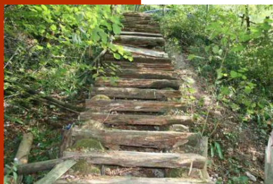
La scalinata, molto degradata, che porta all'ingresso della Grotta Pre Oreak.
