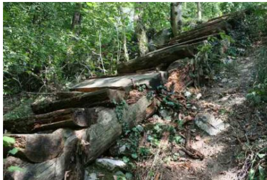
Nel dettaglio si può vedere la pericolosità del manufatto in legno.
