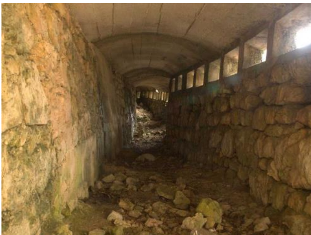
Ponte delle Lastre, l'interno della fortificazione.
