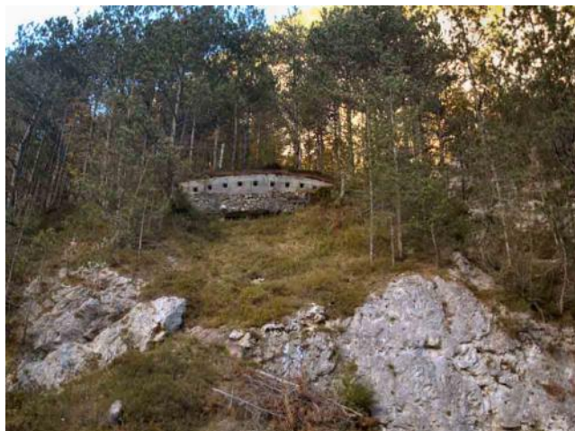
Saletto. Le gallerie difese da una grande fortificazione in cemento e pietra locale.
